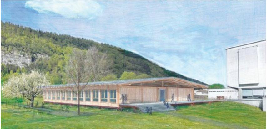
Das vorliegende Projekt setzt sich mit den wertvollen Bestandesbauten und den Qualitäten des Ensembles auseinander. In der Ausrichtung und Geometrie wird der Neubau geschickt und selbstverständlich in das bestehende Gefüge platziert. Durch seine Eingeschossigkeit entsteht keine Beeinträchtigung des schützenswerten Bestandes. Der Neubau wird als einfacher Holzbau konzipiert. Das Gebäude setzt sich auf die bestehende Umgebung auf, die Einzelfundamente unterstützen den Charakter.
